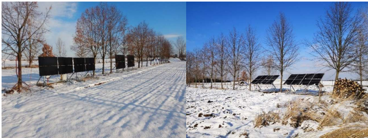
Obr. 4.1-3: Reálná instalace AgFPV systému
